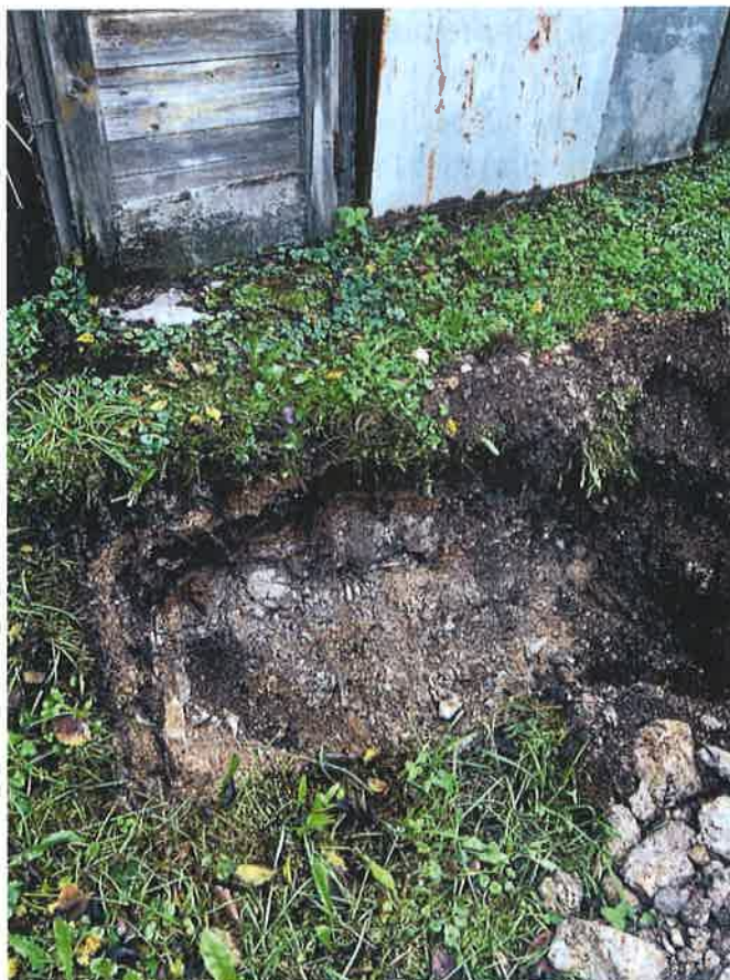
Slika 5. Profil v sondažnem jašku SJ-2 na parceli št. 2080/32.
